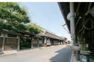
卯之町の町並み 旧宇和街道のまち並みには、老舗旅館や造り酒屋に商家などが残る。国の保存地区にも指定される。
