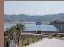
仁淀川河口大橋/土佐市 河口付近は橋を望む公園から、仁淀川と広大な太平洋が一望できる。
