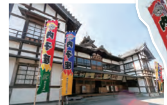
内子座 大正期に建てられた県下最古の芝居小屋。いまもイベントに活用される。 ☎0893-44-2840
