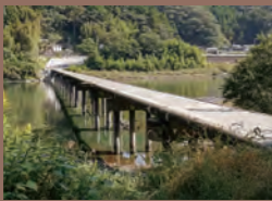
名越屋(なごや)沈下橋/日高村 仁淀川の最下流の沈下橋。いの町と日高村を結ぶ。4ヶ所の待避所がある。
