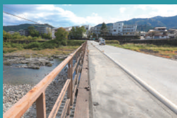
中仁淀橋(越知町) 越知町の中心部に近く、通行量は最多。軽自動車同士はすれ違い可能で、歩道も確保されています。欄干は増水時に取り外されます。
