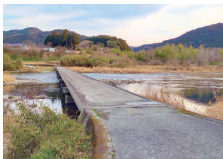
上流部、高知県本山町にある「下津野沈下橋」。吉野川の橋でも高知県なので沈下橋です。
