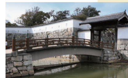
赤穂城跡の大手門前、太鼓橋の下には改修された旧上水道管が見えます。
