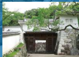
現在の正面玄関に当たる埋門
