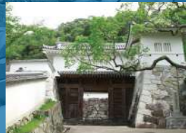
現在の正面玄関に当たる埋門
